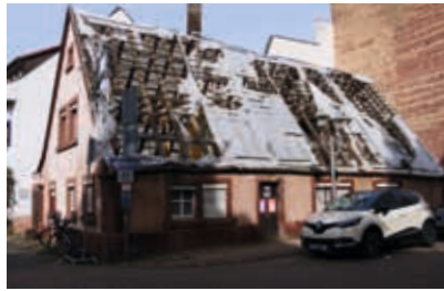
Fischerhaus vor Abriss Foto: Roswitha Claus
